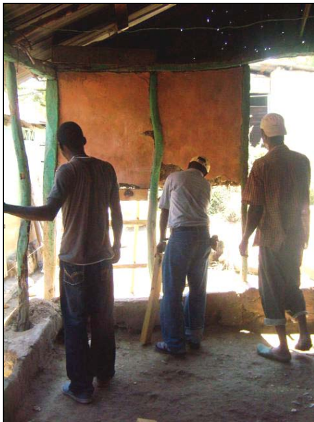
3- On étaie les murs avant d'intervenir
