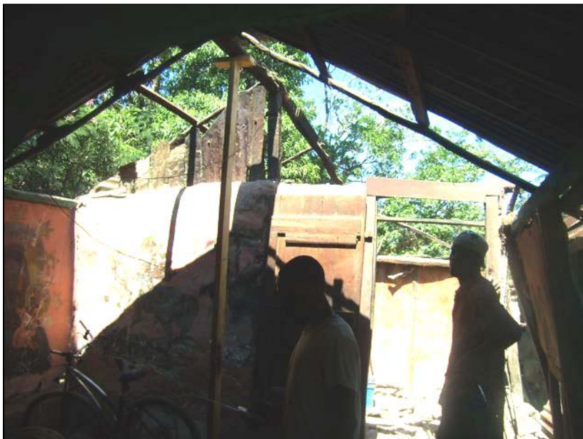
8- La toiture est découverte
