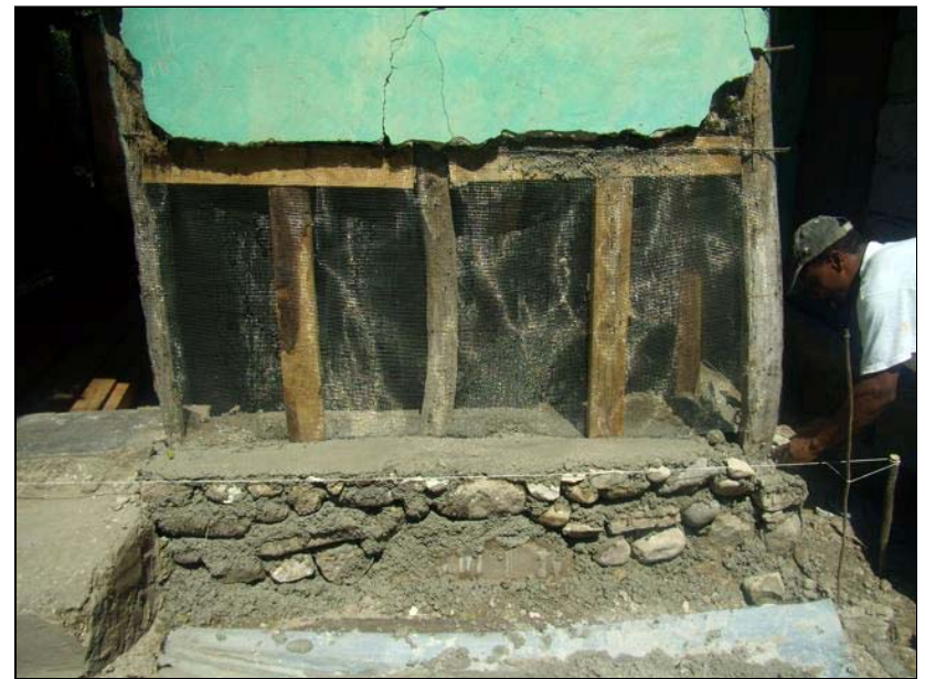
9- Vue de la façade consolidée, avant enduit sur le treillis
