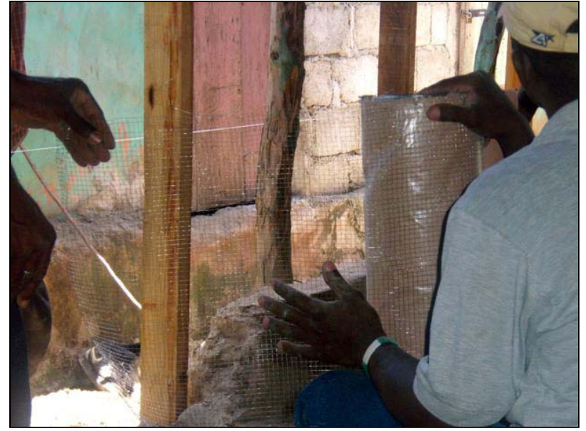
7- Mise en place du treillis métallique avant l'enduit
